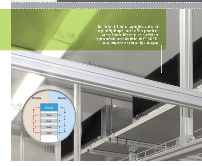
TOP-COOLER VON CONECT ARBEITEN DURCH DIE OFFENEN STRUKTUREN DER IT-COMPACT SYSTEMFAMILIE BESONDERS EFFIZIENT UND BENÖTIGEN KEINE ZUSÄTZLICHE STELLFLÄCHE ODER DOPPELBÖDEN.
