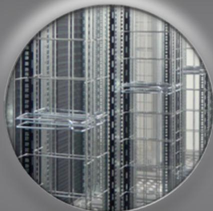
Rackarchitekturen von CONECT kombinieren den Nutzen standardisierter Bauteile mit einer intelligenten Verbesserung der installationstechnischen Details. So verzichten wir auf störende Vertikalholme, nutzen Gitterbahnen auch senkrechtstehend für Kabelführung und die Befestigung von PDU-Leisten. Installationen oberhalb der Racks oder auch auf dem Boden sind ebenfalls möglich. Dabei bleibt alles zugänglich und kann jederzeit geändert werden.
